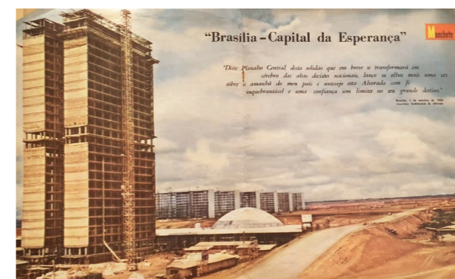
Esplanada em Construção
